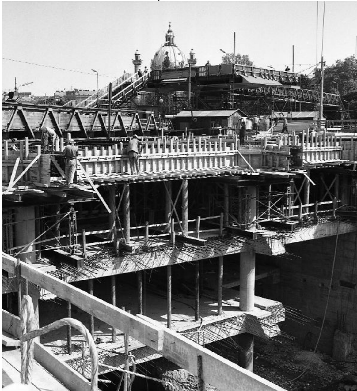
Construction at Karlsplatz 1970
