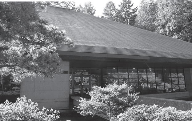
「70大阪万博の三洋館だったアジア研究センターの建物」
